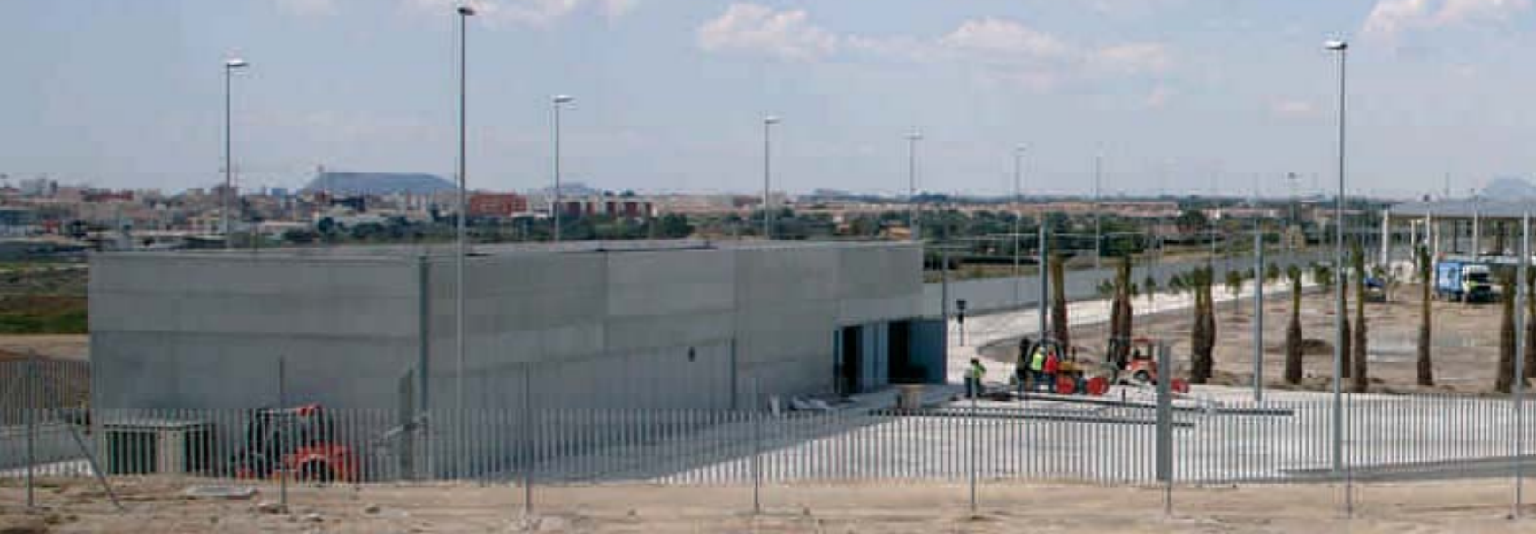
Talleres y cocheras del TRAM, vista general. El Campello. Fondo GTP.
