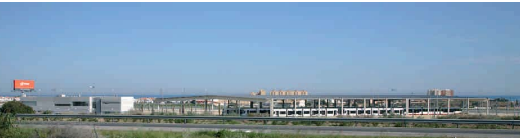
Talleres y cocheras del TRAM, vista general. El Campello. Fondo GTP.
