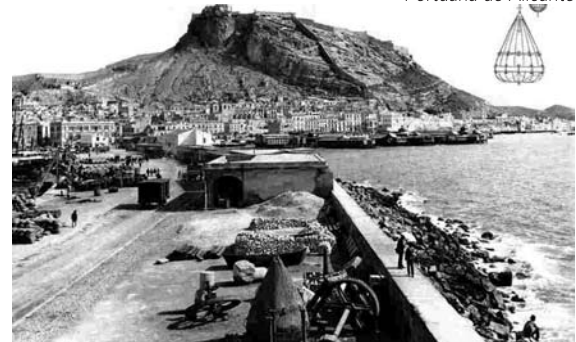
Obras de ampliación y construcción del muelle 14, adosado al dique de Levante. Años treinta. Col. Autoridad Portuaria de Alicante
