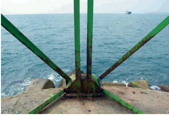
Faro de Alicante. Detalles antes de su restauración. R. Quereda, fotógrafo.
